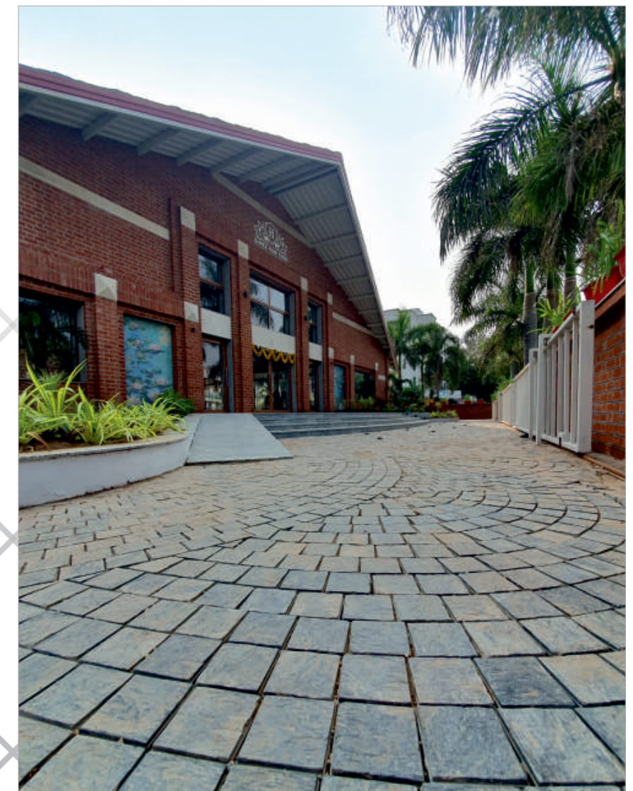
Size : 100 x 100 x 60 mm (Rubber Mould) Size : 100 x 100 x 45 mm (Vibro Compaction Mould)
